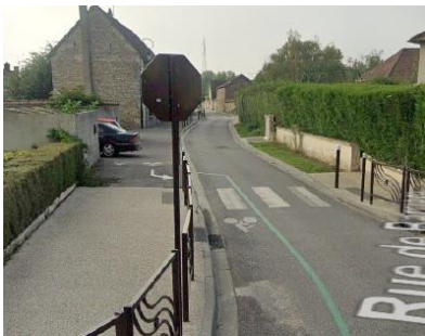
Rue de la Barrière – trottoir partagé trop étroit génère insécurité et réintégration sur la chaussée difficile
